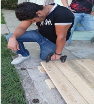
Reforzando la base
