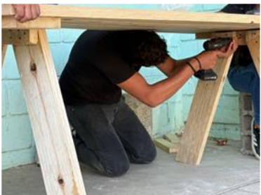
Ensamblando la base con los travesaños
