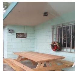
Proyecto realizado, se colocó bajo techo externo de las aulas del TBC.
