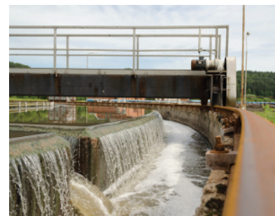
Figura 3.6. Planta de tratamiento de aguas residuales.
