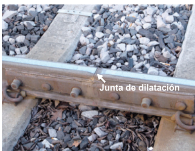
Espacios de dilatación en el diseño de rieles de tren.
